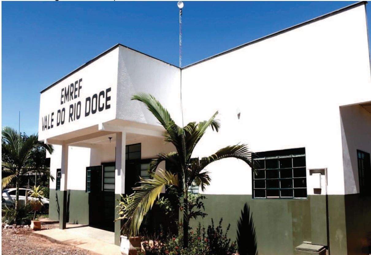
Figura 6 - Quarto prédio da escola - funcionamento de 2008 até a atualidade
