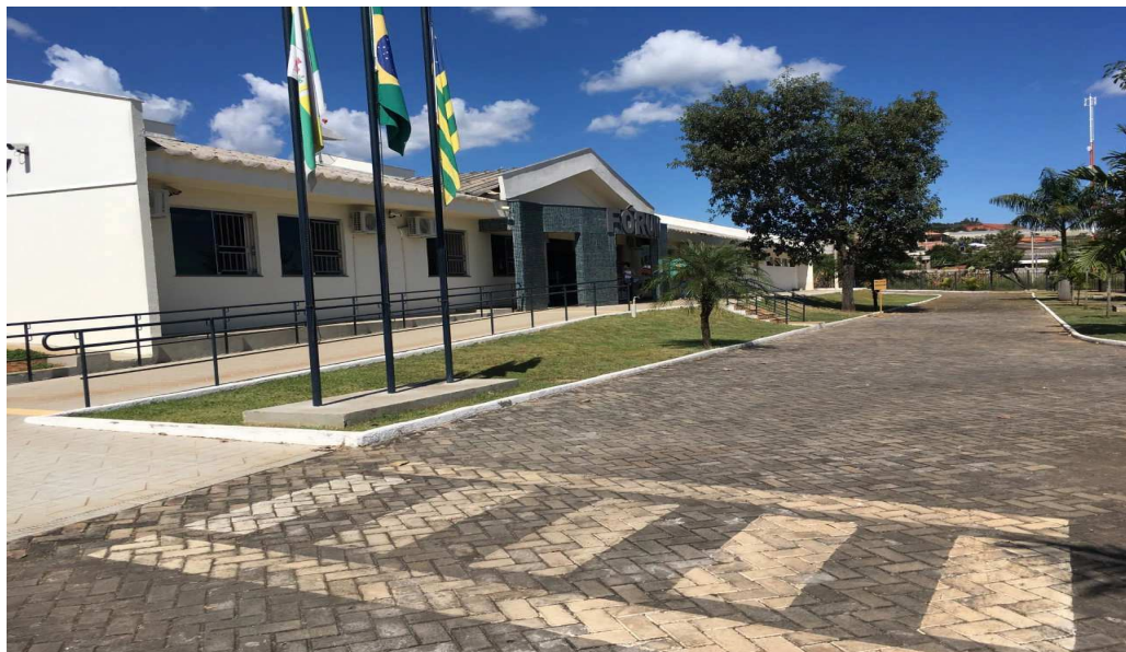
Figura 8 – Rampa na entrada do Fórum de Corumbá
