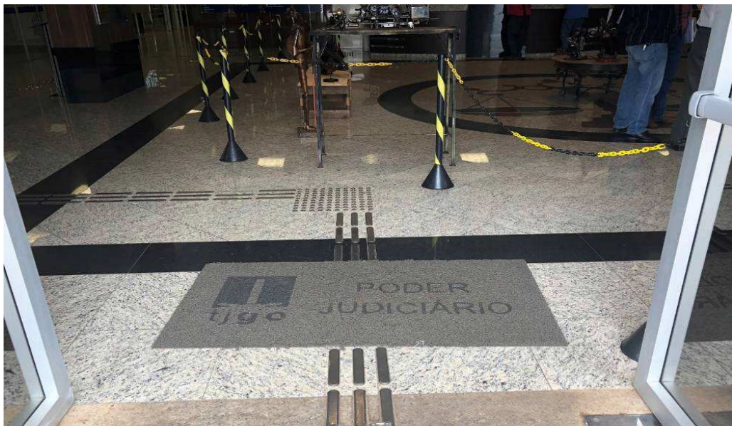
Figura 9 – Forração sobre o piso tátil na entrada do Fórum Cível, Goiânia
