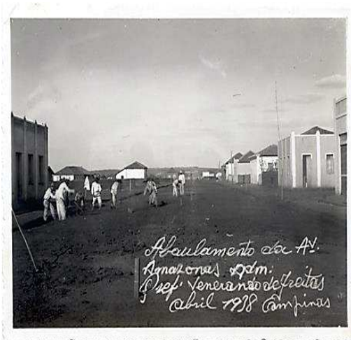
Figura 57- Obras de terraplanagem na avenida Amazonas em 1938.
