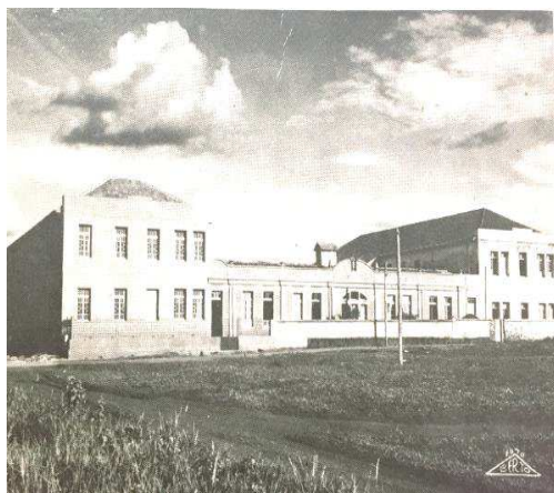
Figura 60- Colégio Santa Clara em 1940, ampliado nos dois lados. Ainda conserva a primeira edificação ao centro. Fonte: MENEZES, 1981.
