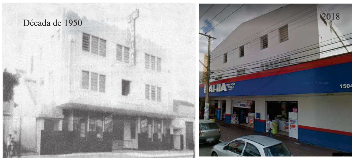
Figura 106- Transformação do uso Edifício do Cine Campinas , 1950, na avenida 24 de Outubro e o seu uso atual em 2018.
