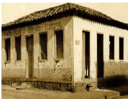
Figura 1- Casa na rua Bonfim (José Hermano), correspondente à descrição de Gomes, 2012. Campinas da década de 1920.
