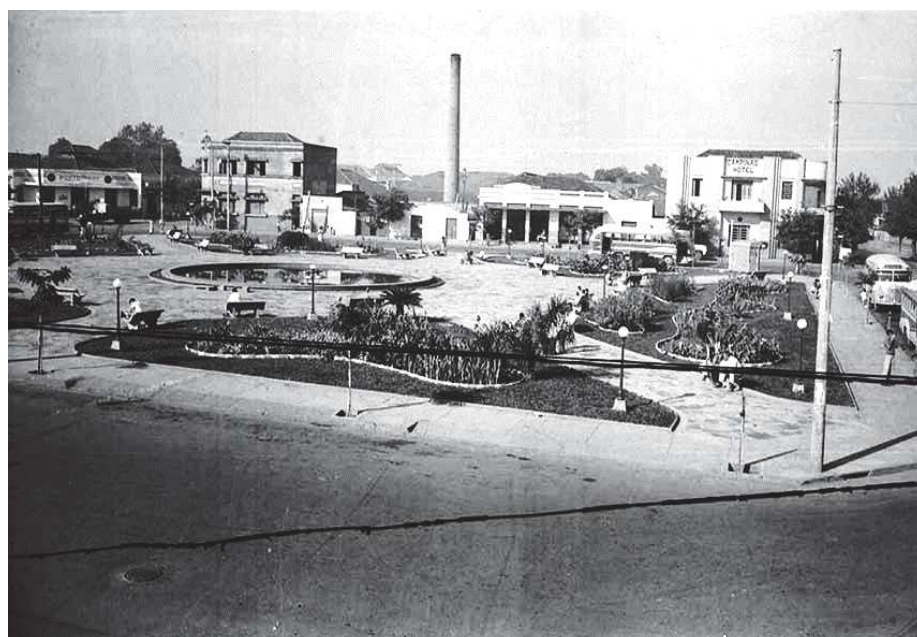
Figura 76 - Coreto da praça Joaquim Lúcio na década de 1960. Ao fundo, a chaminé da olaria.
