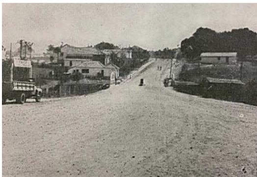
Figura 83- Implantação da rede de águas pluviais na rua Jaraguá e ponte sobre o córrego Cascavel. Fonte: BRITO, 1965.
