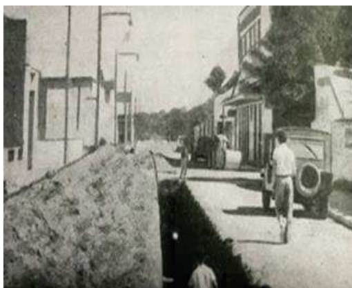
Figura 79 – Implantação da rede de águas pluviais na rua Honestino Guimarães, antiga Pernambuco, na década de 1960. Fonte: BRITO, 1966.
