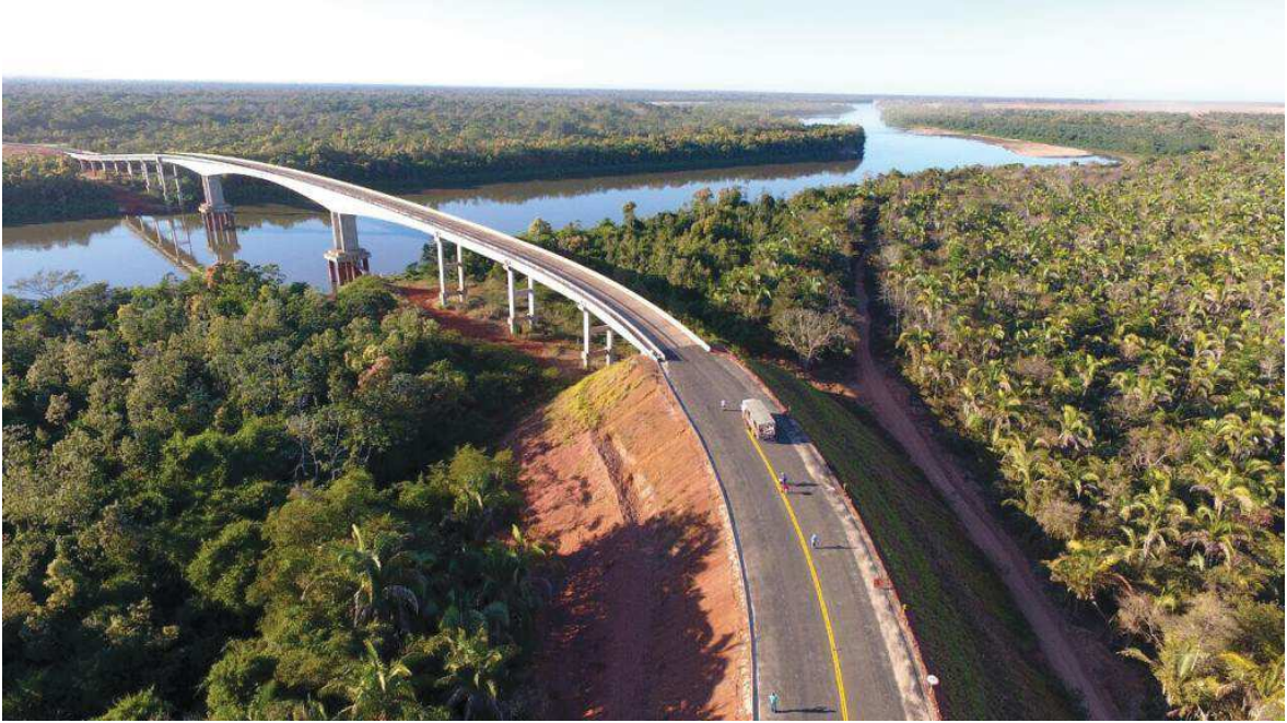
Figura 13 – Ponte localizada na região do Araguaia, na divisa dos estados de Mato Grosso e Goiás. Fonte: Google Imagens
