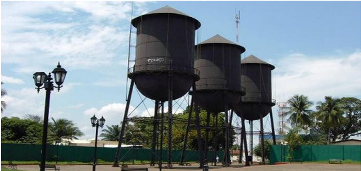
Figura 16 - As três caixas-d'água em Porto Velho
