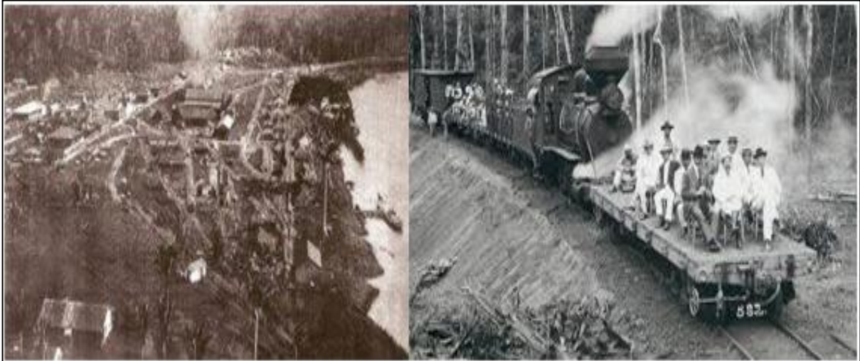
Figura 3 - Início do povoado de Porto Velho e construção da ferrovia
