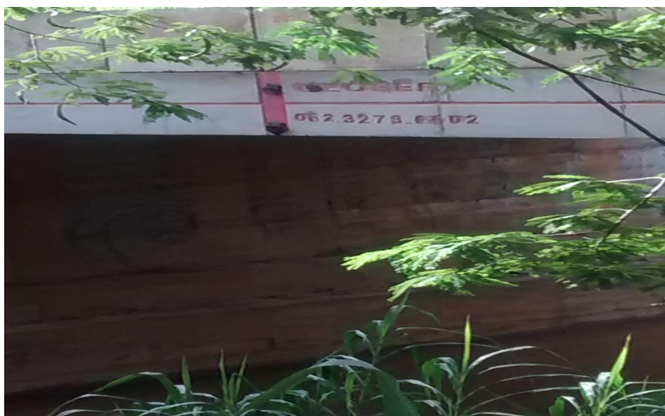
Imagem 28. Ponte da ETE, no Município de Rio Quente Fonte: Arquivo Pessoal, 2015
