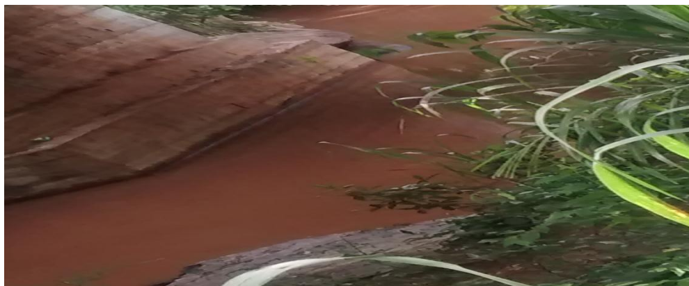
Imagem 29. Ponte da ETE, no Município de Rio Quente Fonte: Arquivo Pessoal, 2015
