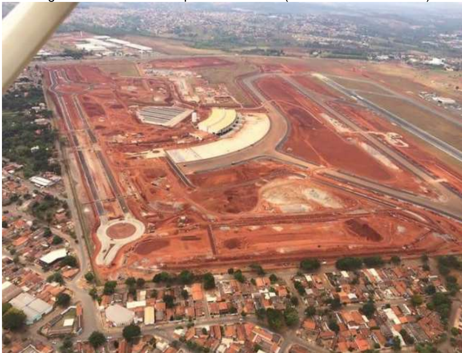
Figura 6 – Obras do Aeroporto de Goiânia (18 de fevereiro de 2016)
