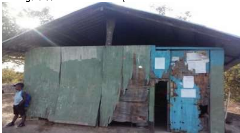
Figura 55 – Escola – construção de madeira e telha eternit
