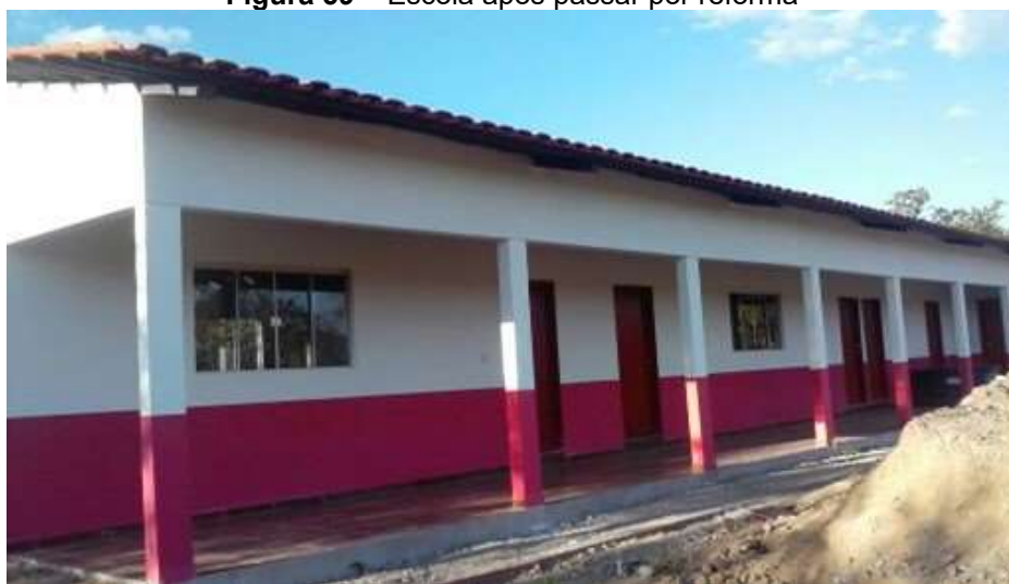
Figura 59 – Escola após passar por reforma
