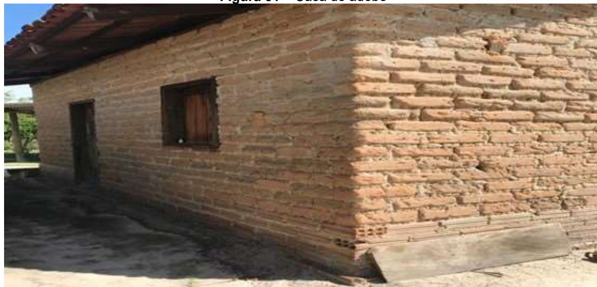
Figura 51 – Casa de adobe
