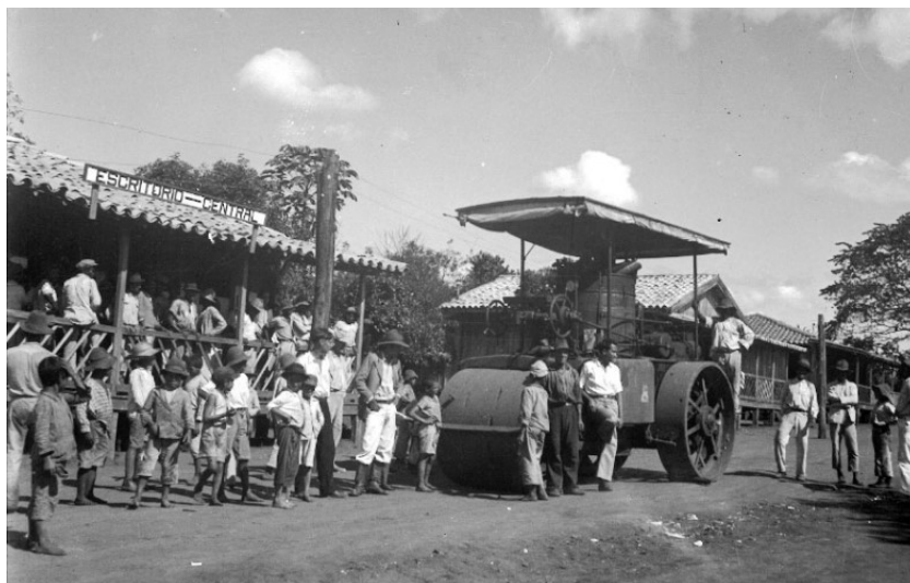
Figura 11: Foto do escritório geral de obras, com o rolo compressor para abrir as ruas em 1934. Fonte: Jornal O popular.
