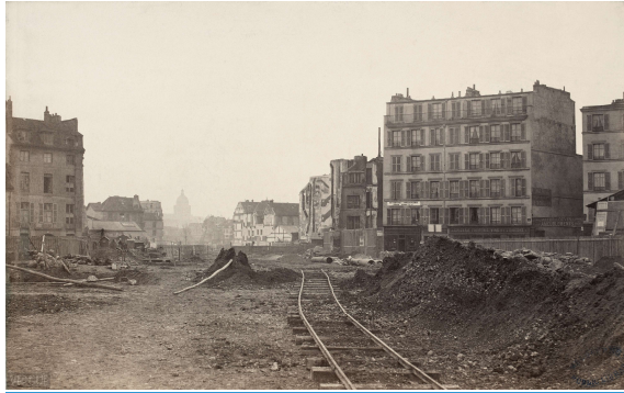
Figura 7: Boulevard Henri IV, em construção em Paris, uma das intervenções de Haussmann. Fonte: Museu Carnavalet, História de Paris.
