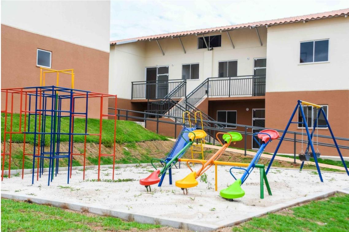
Figura 31 – Playground do empreendimento VI
