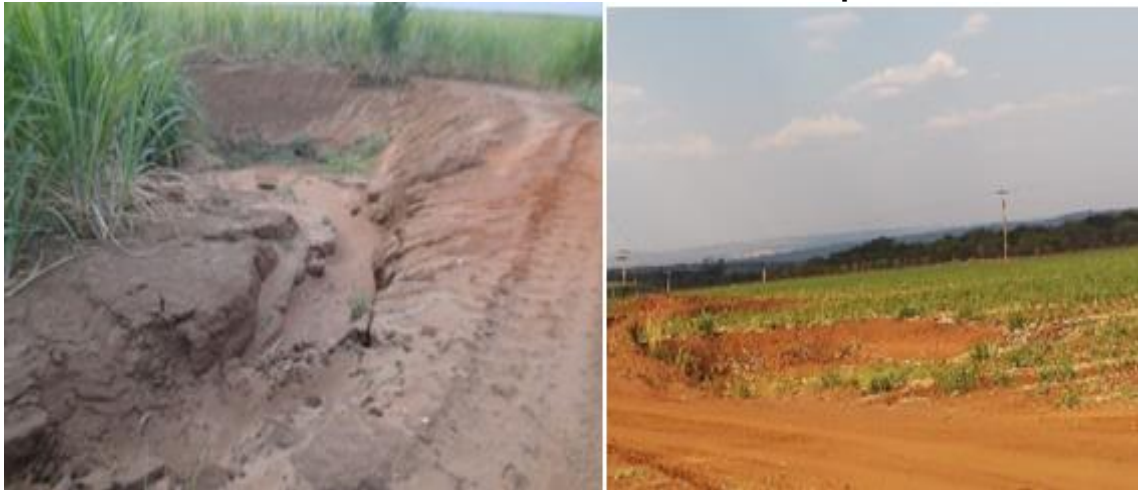
Figura 36 - Início do processo erosivo em área de canavial, estrada vicinal rumo à Pousada das Araras em Serranópolis
