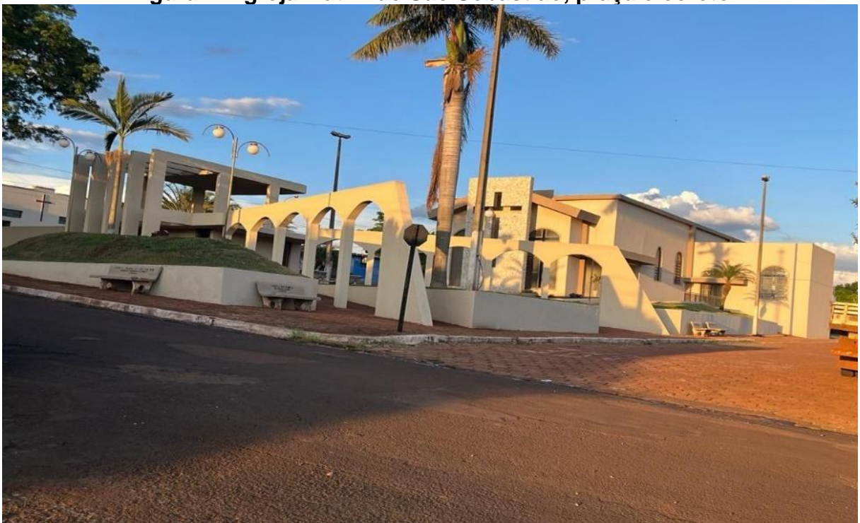
Figura 2 - Igreja Matriz de São Sebastião, praça e coreto
