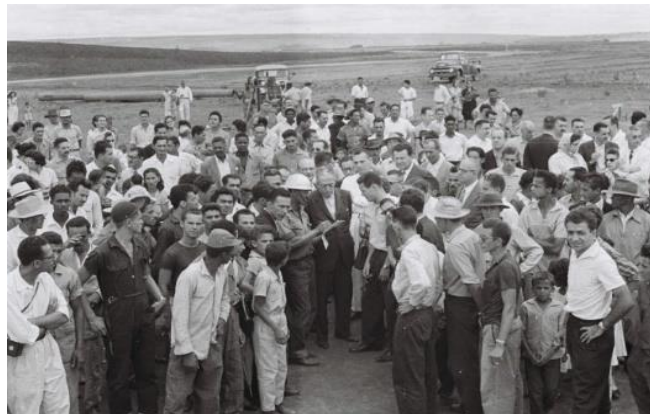
Foto 20: Israel Pinheiro em um canteiro de obras
