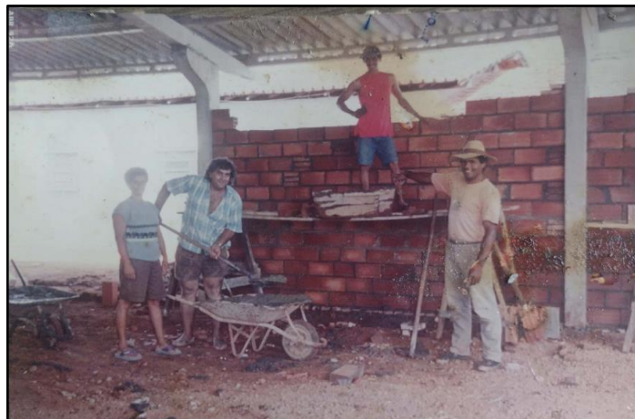
Figura 09 - Mutirão de trabalhadores na construção do Sindicato dos Trabalhadores Assalariados de Goianésia - GO.
