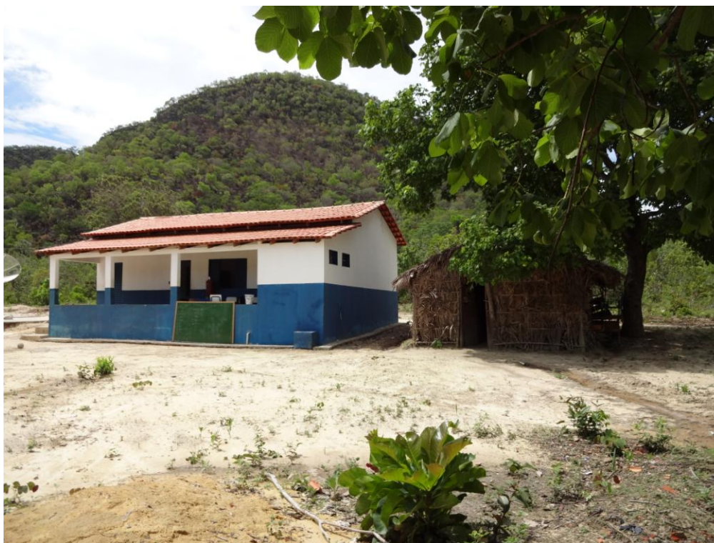
Fotografia 3 - Escola Municipal Areia - Comunidade Areia - Novo prédio - 2º semestre de 2012
