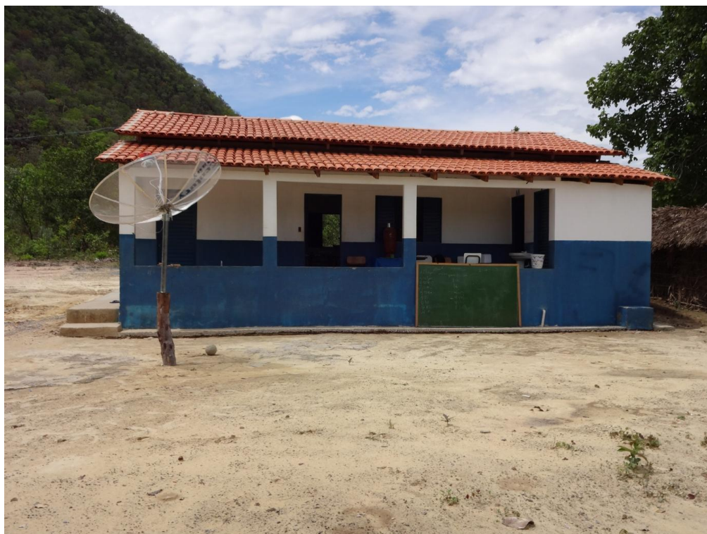
Fotografia 4 - Escola Municipal Rio Areia - Comunidade Areia - Novo prédio - 2º semestre de 2012
