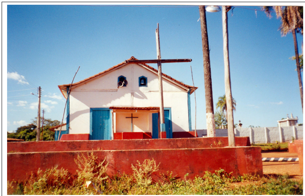
Figura 01- Aspecto frontal do templo católico, construído, provavelmente na primeira metade do século XVIII e ampliado no início do século XX, em torno do qual estão construídas a maior parte das habitações de Capela de Sant'Ana.
