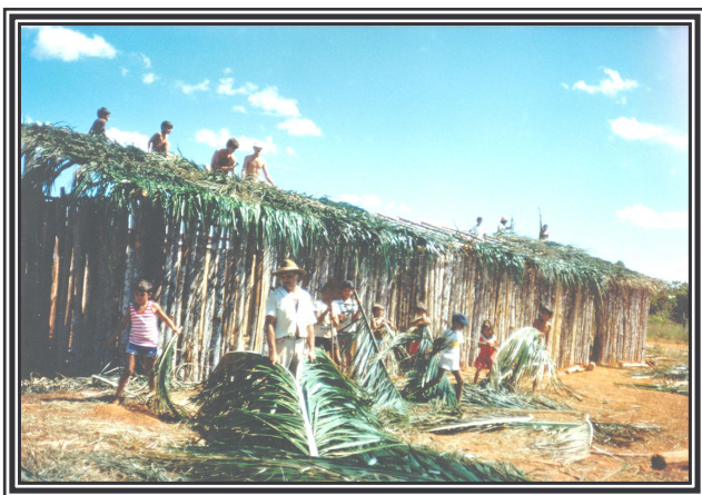
Figura 8: Escola construída em mutirão
