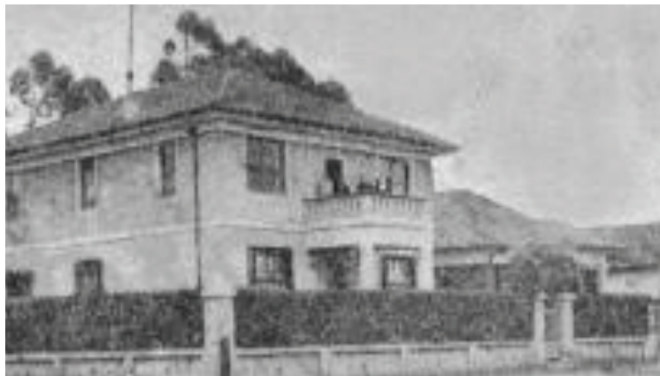
Figura 7 – Sede da União Sul Brasileira da IASD, na capital de São Paulo. (PRESTES-FILHO, 2007).
