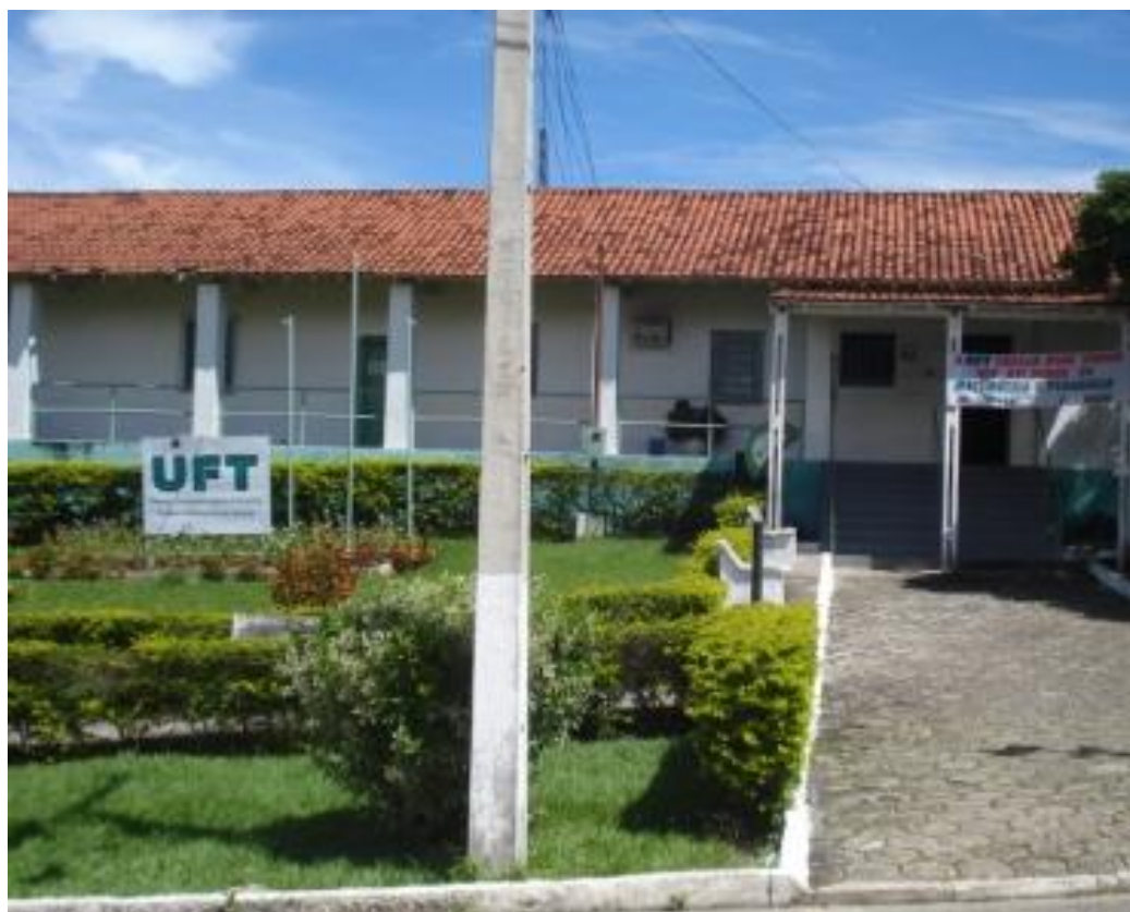
Figura 2 – Prédio onde funcionava a Unitins em Arraias (Atualmente, Campus “Velho” da UFT)
