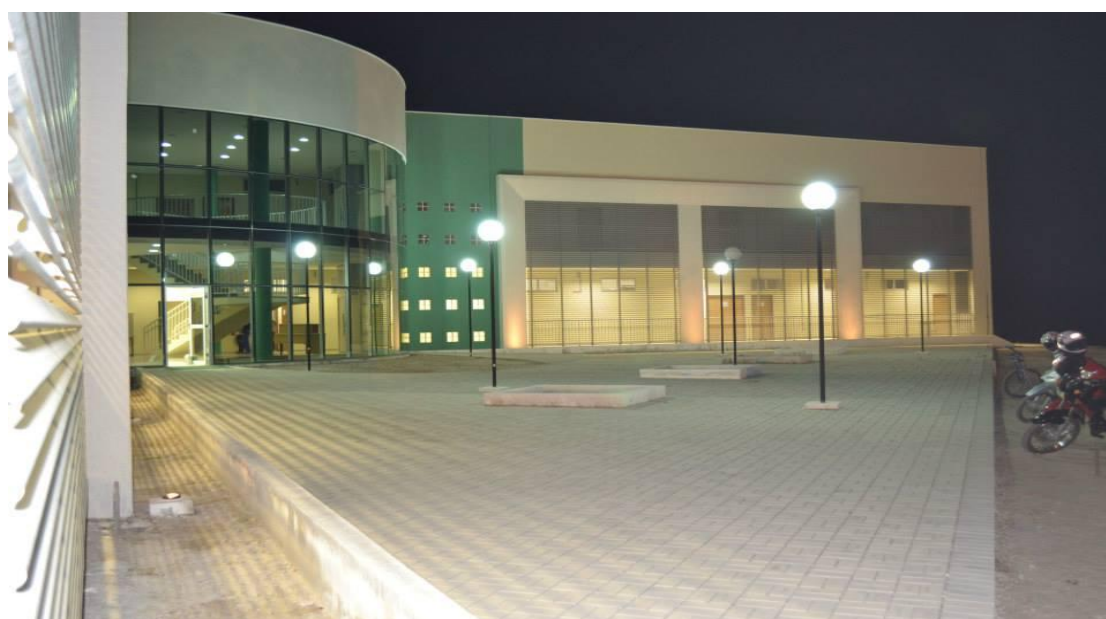
Figura 14 - Visão noturna do prédio BALA – Campus “Novo” da UFT em Arraias
