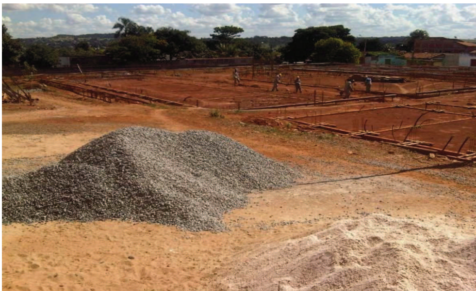
Figura 04: Alicerce da construção da Nova Escola Padrão Século XXI.
