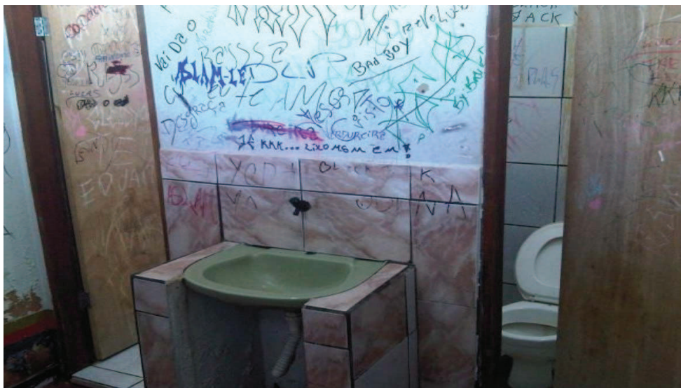
Banheiros da fábrica de sabão
