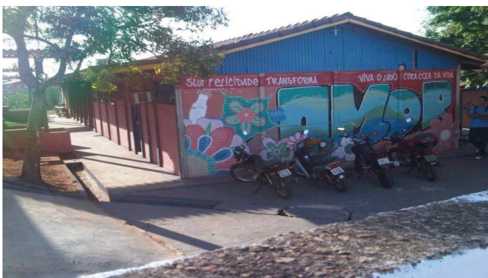
Colégio Estadual Nazir Safatle. Antes da demolição.
