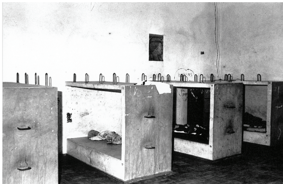
Figura 3: Dormitórios com camas de concreto armado.
