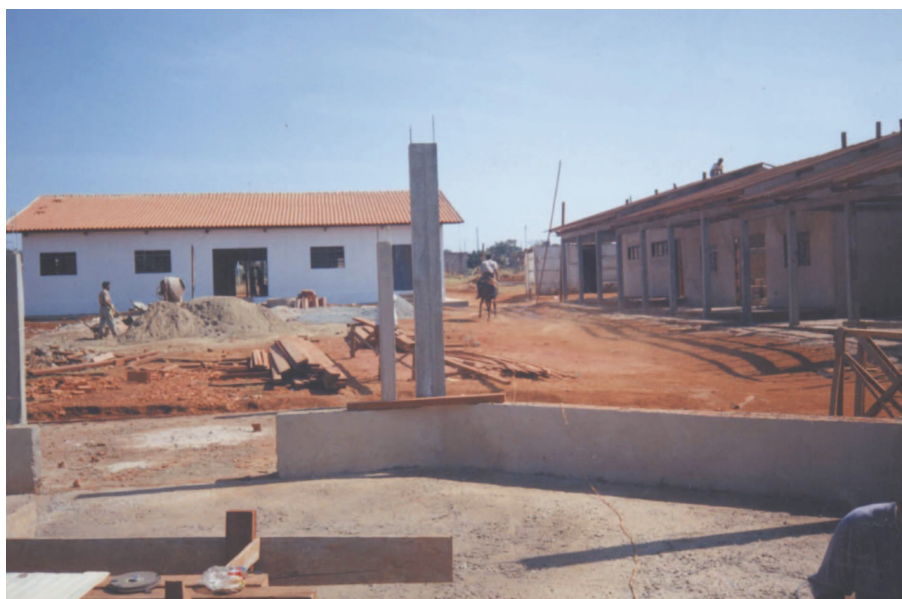
Figura 16: Construção do novo espaço físico do CEPAJ.
