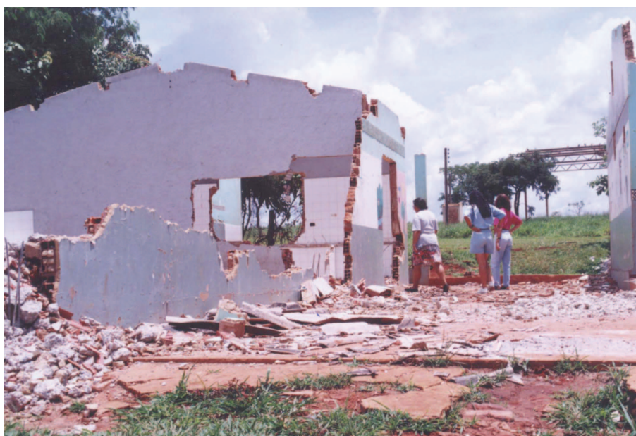
Figura 15: A demolição do refeitório do CEPAJ.
