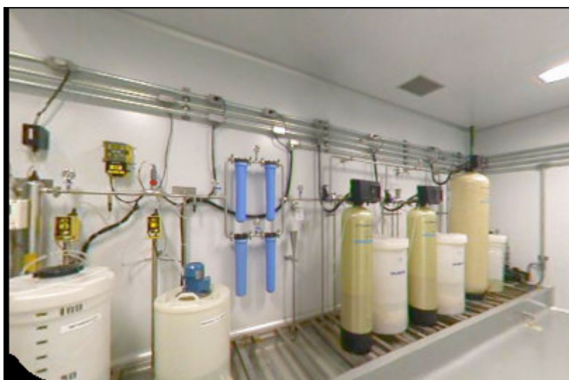
FIGURA 5: Vista parcial do laboratório de testes da Estação de Tratamento de Efluentes da NEOQUÍMICA em Anápolis-GO
