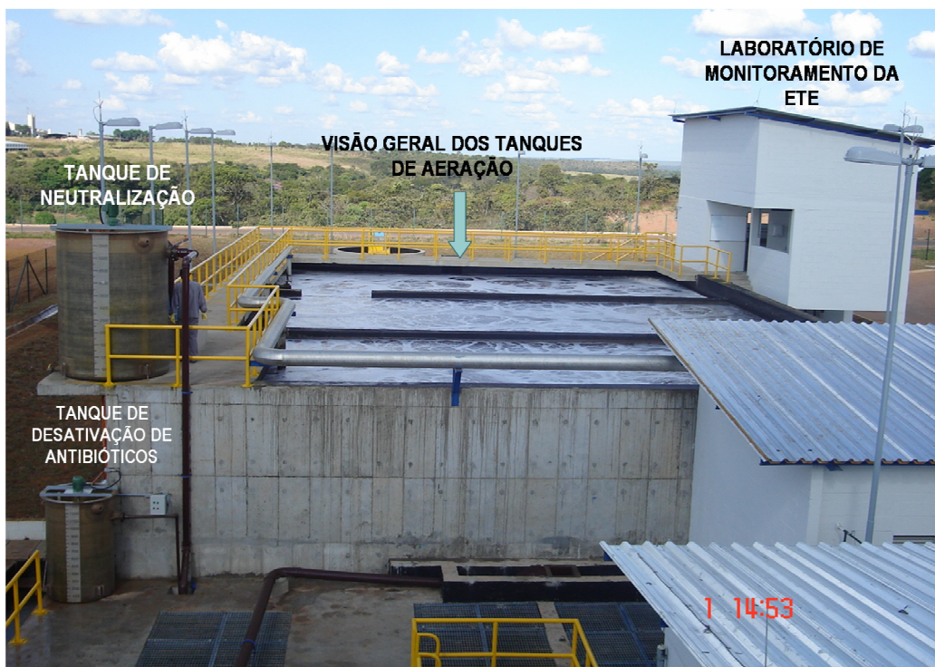
Figura 7 – Tratamento Secundário da ETDI do Laboratório Neo Química
