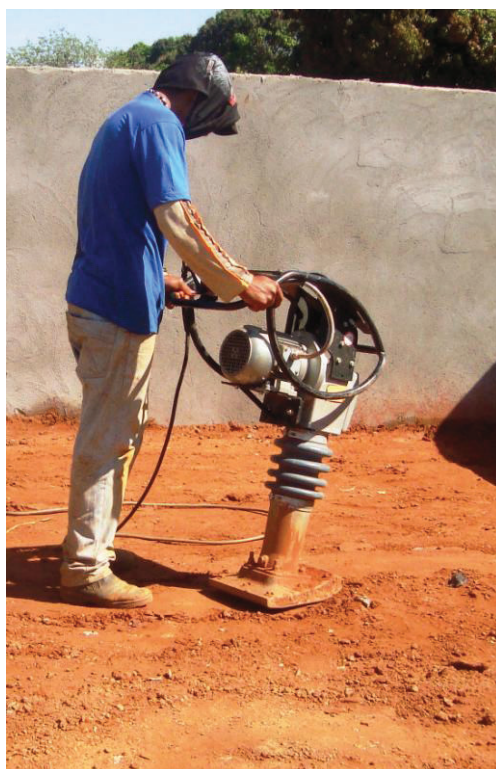
Figura 4: Compactador de percussão elétrico em atividade no ensaio
