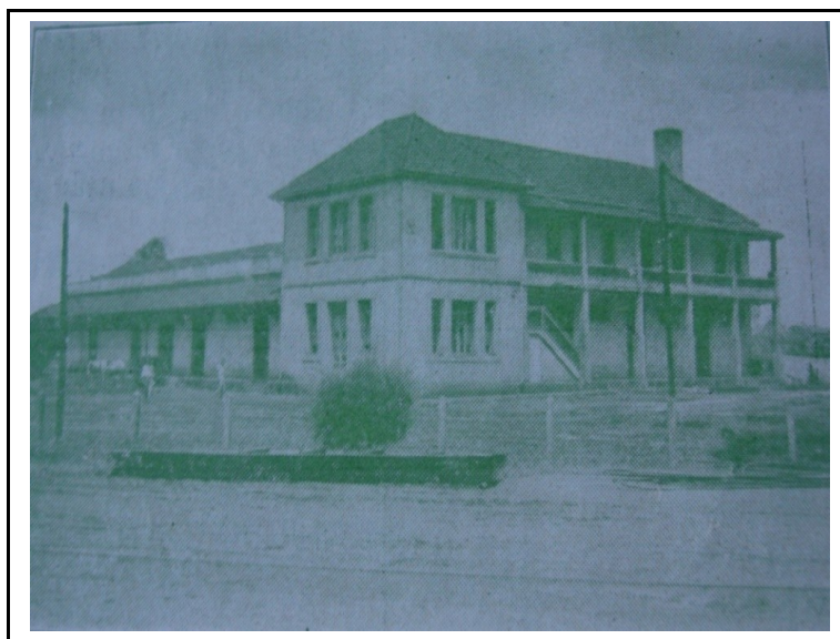
Figura 28 – Cia. Goiana de Armazéns.
