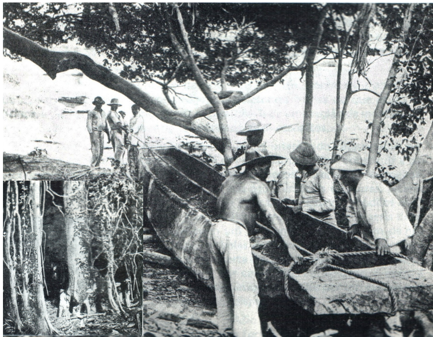
Ilustração 15 - fabricação de uma igarité no século XIX. Ao lado esquerdo, um homem cortando uma grande árvore para a fabricação da igarité. Fonte: Coudreau, Henri, 1855-1899 - Viagem à Itaboca e ao Itacaiúna. Belo Horizonte; Ed. Itatiaia; São Paulo: Ed. Da Universidade de São Paulo, 1980.
