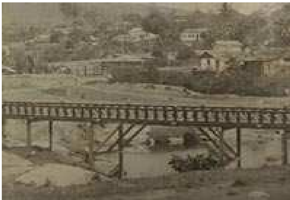
Foto 15: A 1ª Ponte do Rio das Almas
