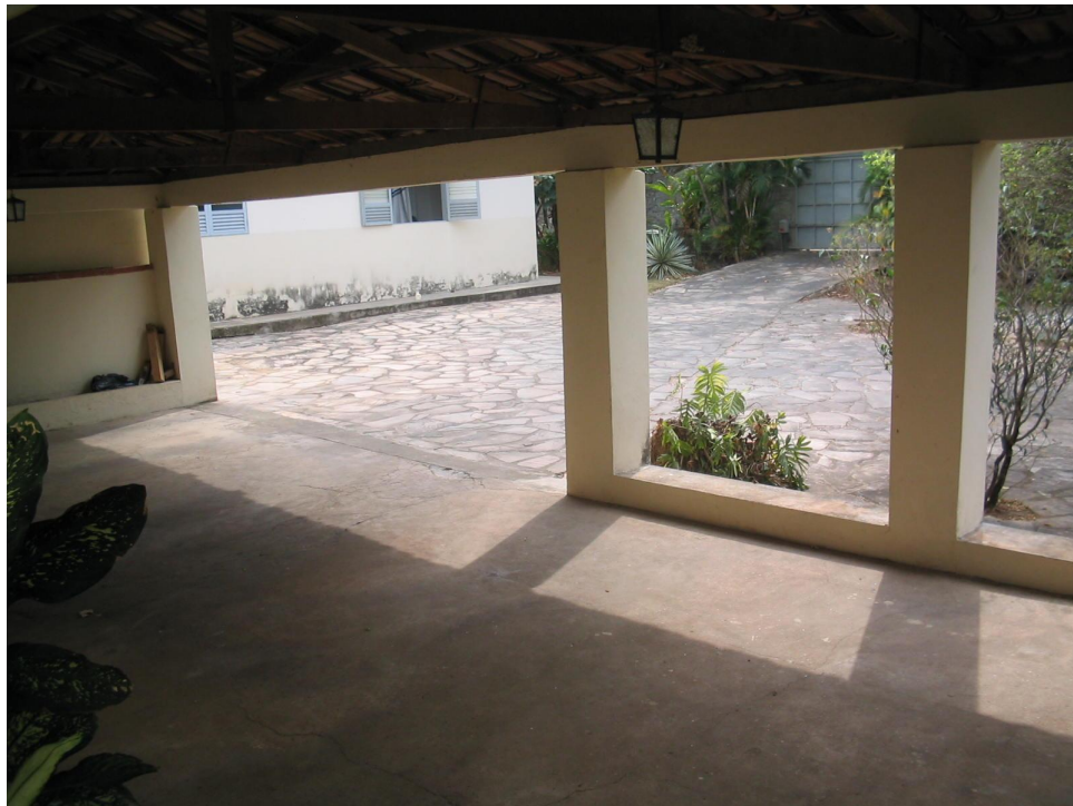
FIGURA 14 – Estacionamento ao lado da horta, construção preservada (PRUDENTE, 2006).
