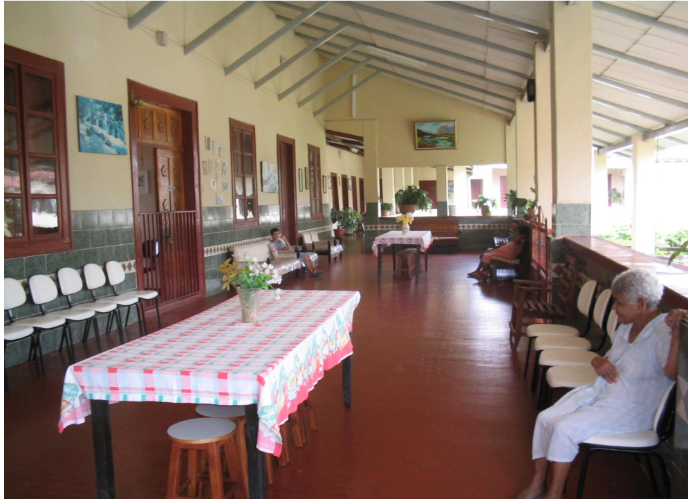
A 28 dos quartos dos internos. Camas de hospital, armários, janelas e pisos velhos (PRUDENTE, 2006).
