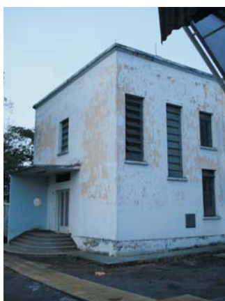
FOTO 17 - Edifício da Antiga RFFSA, Av. Independência Qd. 149, Centro (Demolido em 2006) Fonte: Ciro Augusto de Oliveira e Silva (2006)
