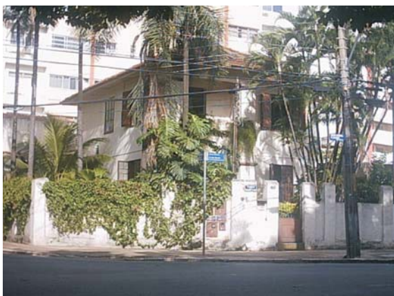
FOTO 43 - Ed. Residencial, Alameda dos Buritis, esq. c/ Rua 12, Qd 47, Centro Fonte: Ciro Augusto de Oliveira e Silva (2006)
