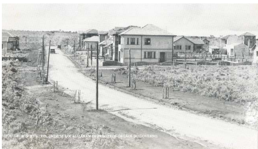
Fig. 35 - Foto da Rua 20, no Centro, no início da década de 1940. Fonte: Oscar Sabino Júnior (1980).
