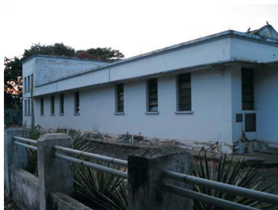
FOTO 16 - Edifício da Antiga RFFSA, Av. Independência Qd. 149, Centro (Demolido em 2006) Fonte: Ciro Augusto de Oliveira e Silva (2006)
