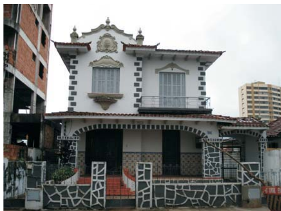
FOTO 45 - Ed. Residencial / Comercial, Rua 29, Qd 83, Lt 28, Centro Fonte: Ciro Augusto de Oliveira e Silva (2006)
