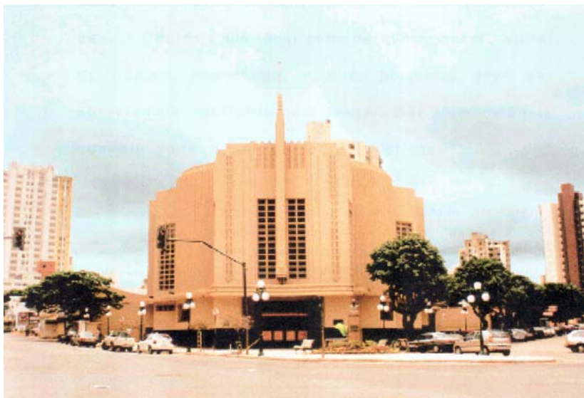
Fig. 45 - Teatro Goiânia, no Centro. Projeto Cine-Teatro Goiânia Fonte: Projeto Goiânia 21: Operação Centro, Etapa 2, (1998).
