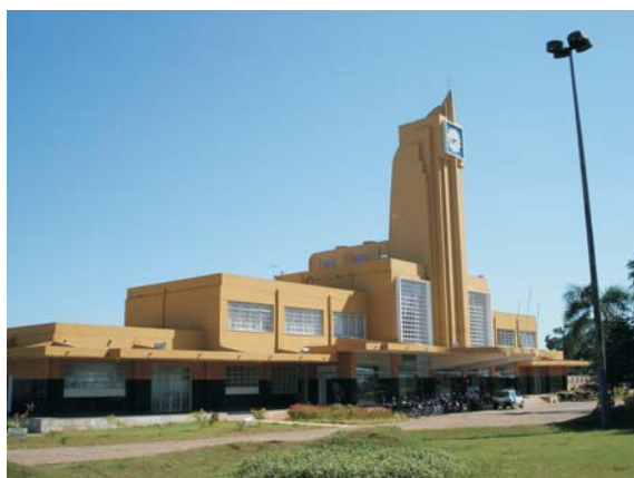
FOTO 11 - Ed. da antiga Estação Ferroviária Av. Independência esq. c/ Av. Goiás, Centro Fonte: Ciro Augusto de Oliveira e Silva (2006)
