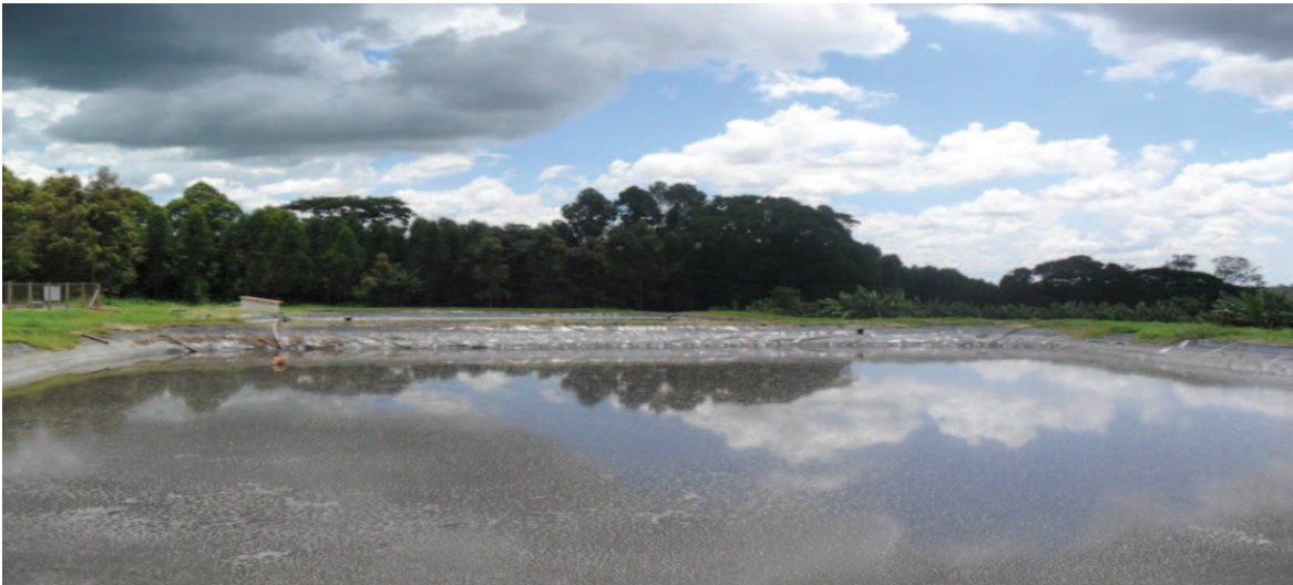
Figura 4 - Lagoas de Estabilização
