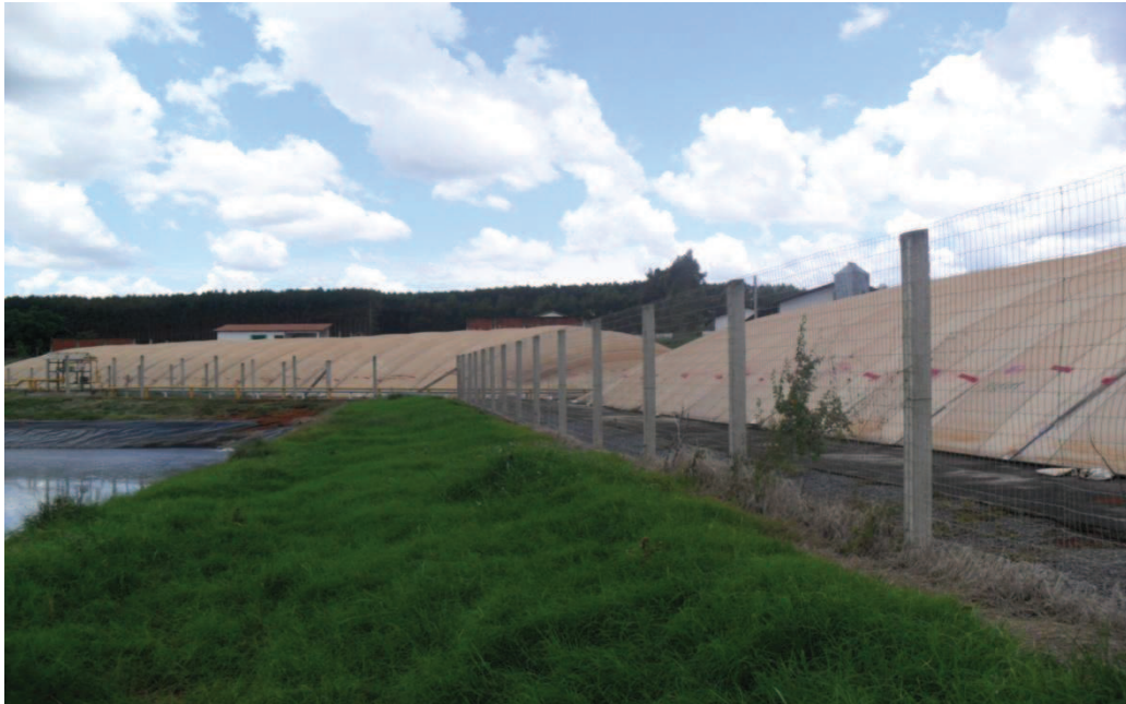
Figura 3 - Biodigestores atualmente instalados na suinocultura
