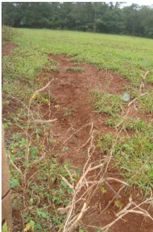
Figura 20 – Ravinamento em área de pastagem no Município de Itumbiara-GO, 30/04/2011. Fonte: R. M. Pereira.
