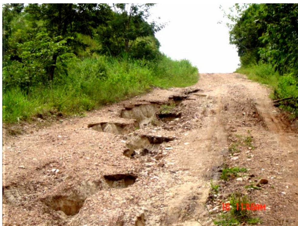
Figura 34. Data 18/04/2006. Destaque para erosão na estrada, provocada pelo escoamento superficial das águas, bem como as características do solo. Foto: Daniela Almeida Oliveira, 2007.
