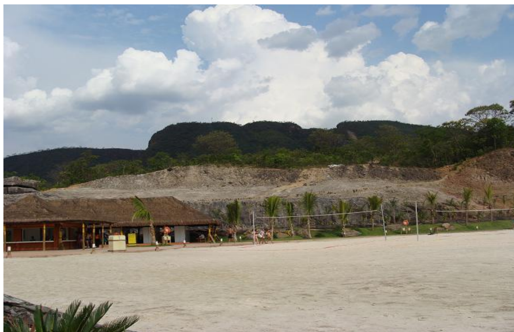
Figura 23 – Escavação do estrato rochoso. Fonte: TRIGUEIRO, 2009.
