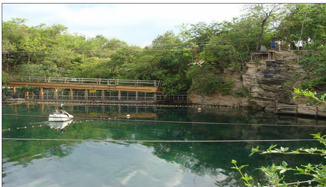
Figura 3 – Construção de Ponte que agride a Mata Ciliar. Fonte: TRIGUEIRO, 2009.
