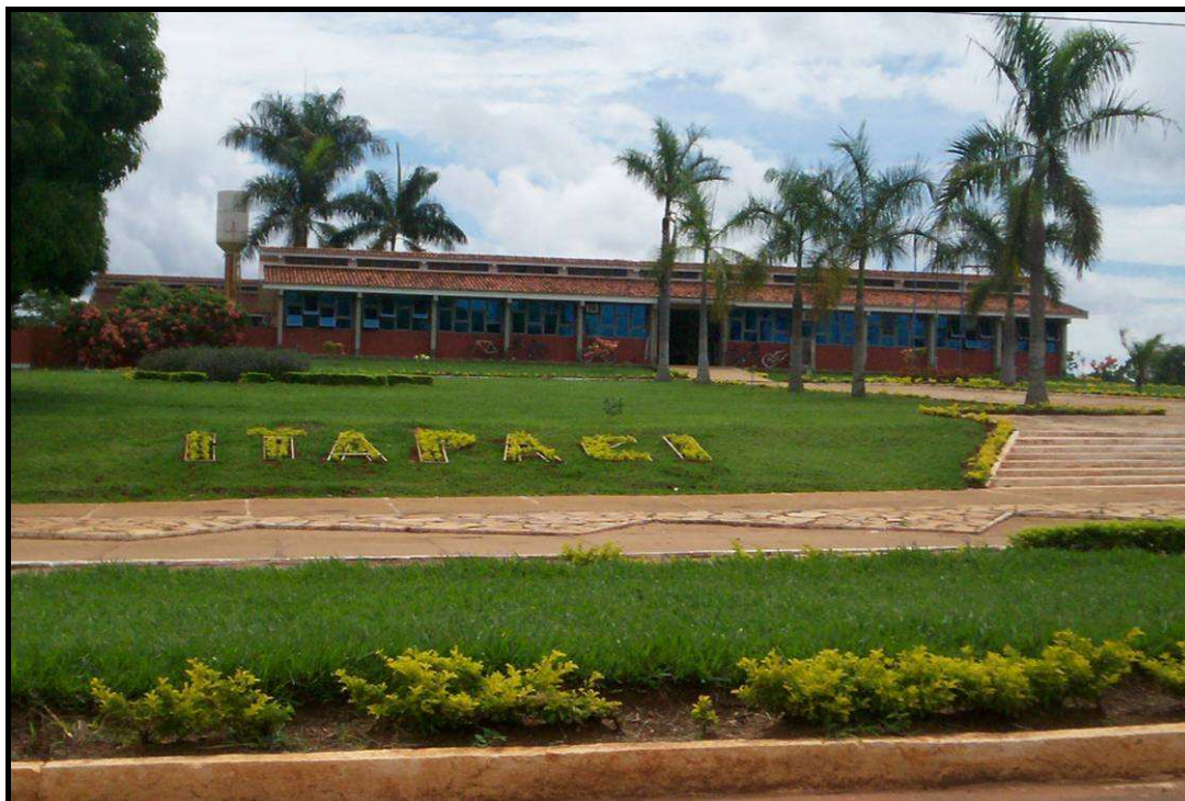
Figura 21: Vista da entrada da prefeitura municipal de Itapaci - GO
