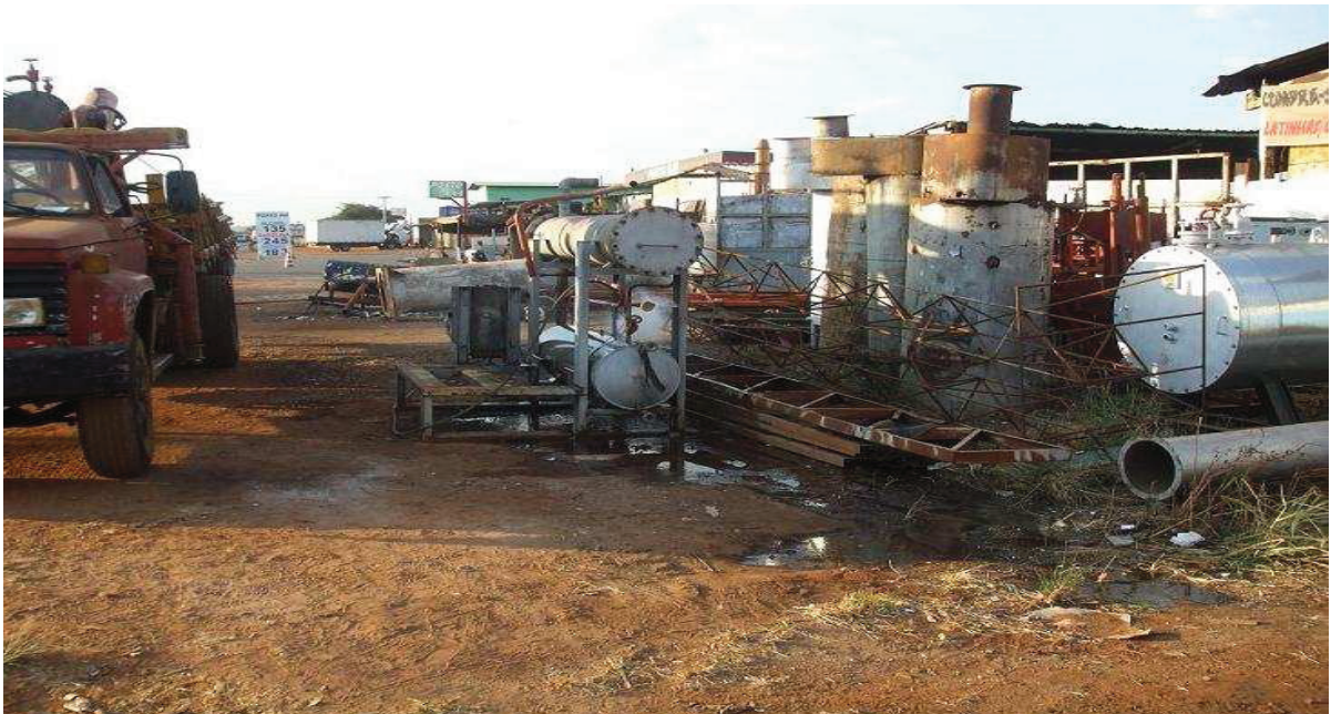
Figura 6 - Vazamento do gás amônia em Goiânia em ferro velho.
