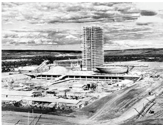
Figura 6: Fotografia – Construção de Brasília 2
