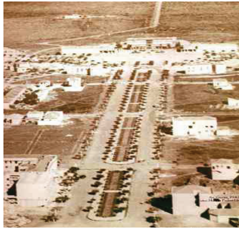
Figura 5: Fotografia – Construção de Brasília 1
