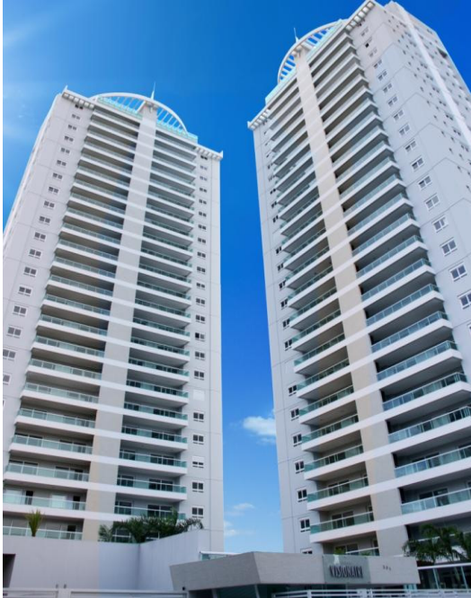
Figura 24 - torres Renoir e Manet. Fonte: Toctao Engenharia.
