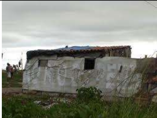
Figura 12 - Setor J. D. Tropical, em Goiânia, fundo do condomínio Lisboa, 2010.
