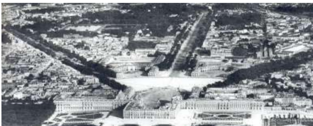
FIGURA 7 - Vista aérea de Versailles, com o palácio em primeiro plano e a cidade em segundo, destacando as ruas em rígida formação em perspectiva de ponto de fuga central. Fonte: KOSTOF, 1991, p.208.
