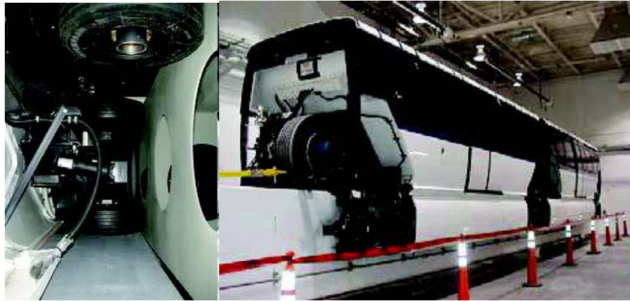
Figura 15: Detalhes de como os carros são presos as vigas de rolamento no sistema monotrilho do tipo Alweg (o tipo mais utilizado).
