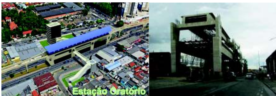
Figura 19: Maquete eletrônica da Estação Oratório, à direita, e imagem da obra desta, em construção, à esquerda.
