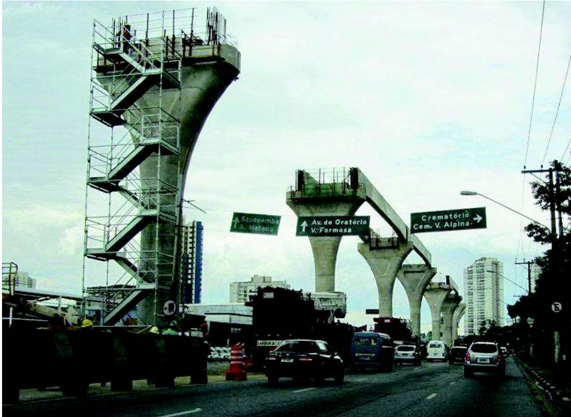
Figura 18: segmento, com colunas de 15 metros de altura, acima da linha das árvores, em construção na cidade de São Paulo, para implantação de monotrilho.
