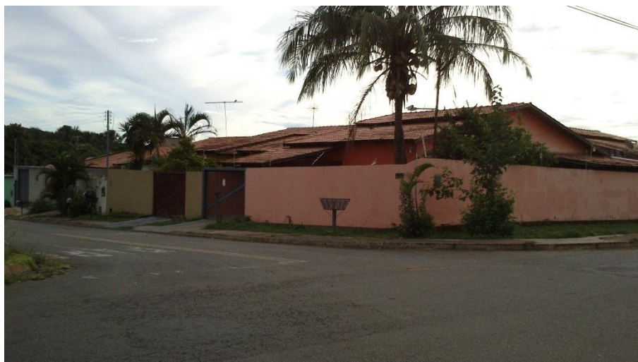
Figura 48 - Tipologia das residências
