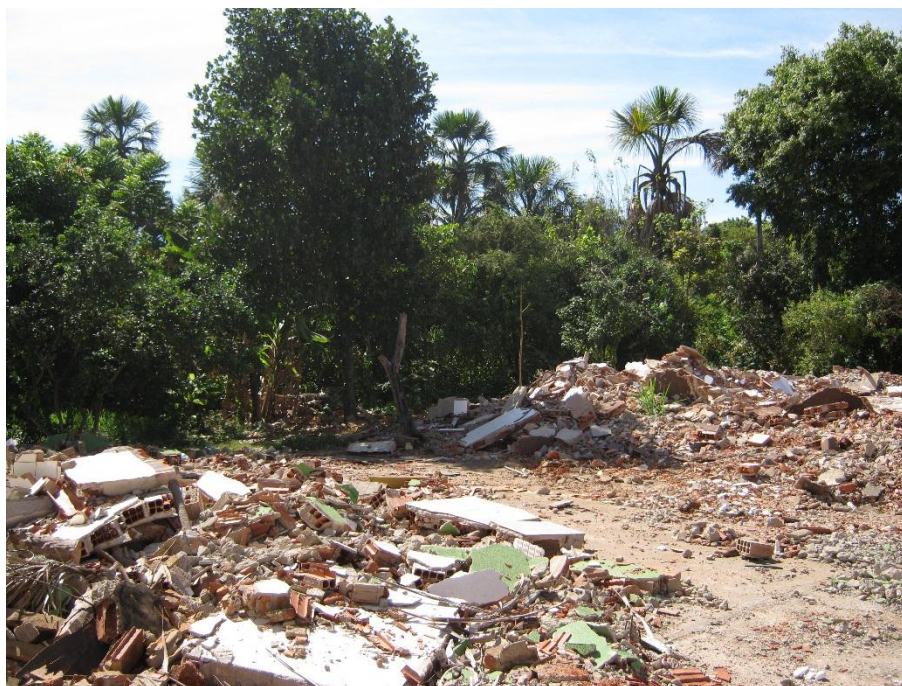
Figura 57- Entulho proveniente das demolições / remoção das famílias Alameda Carlos Di Trano. Fonte: Fotos tiradas pela autora, Janeiro, 2014.
