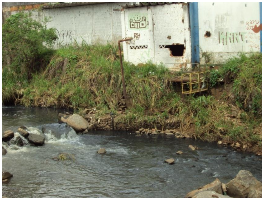
Figura 32 - Existência de construções nas margens - Av. Anhanguera
