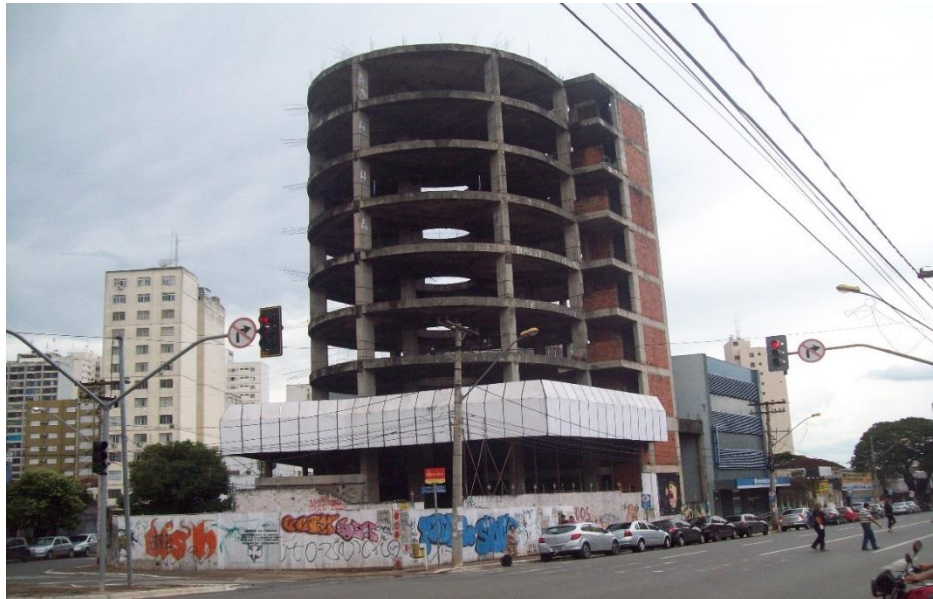
FIGURA8. IMÓVEL ABANDONADO-Av. Araguaia com rua 2 Setor Central.
