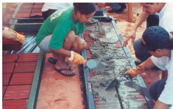
Figuras 32 e 33 – Forma e confecção das placas de tijolos na Tecnologia Beno.
