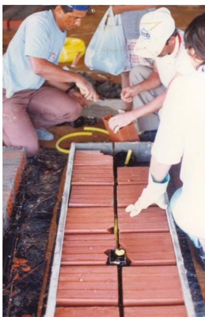
Figura 34 – Confecção da placa com duto de instalação elétrica, já previsto.
