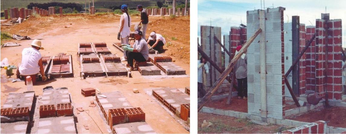
Figuras 35 e 36 – Processo de secagem e montagem das paredes com as placas.
