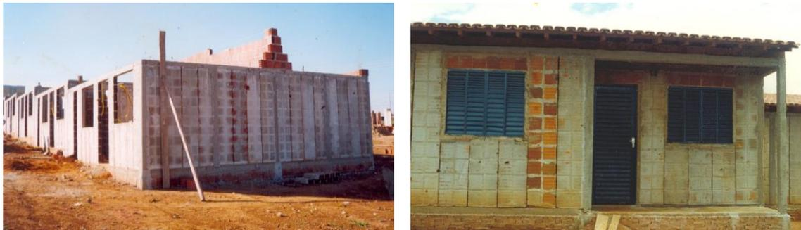
Figuras 37 e 38 – Paredes montadas e início das empenas. Casa semi-pronta.
