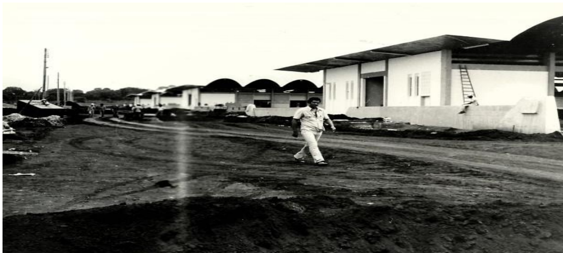
Figura 12: Vista Lateral dos Pavilhões da Central de Abastecimento de Goiás – CEASA-GO – em acabamento
