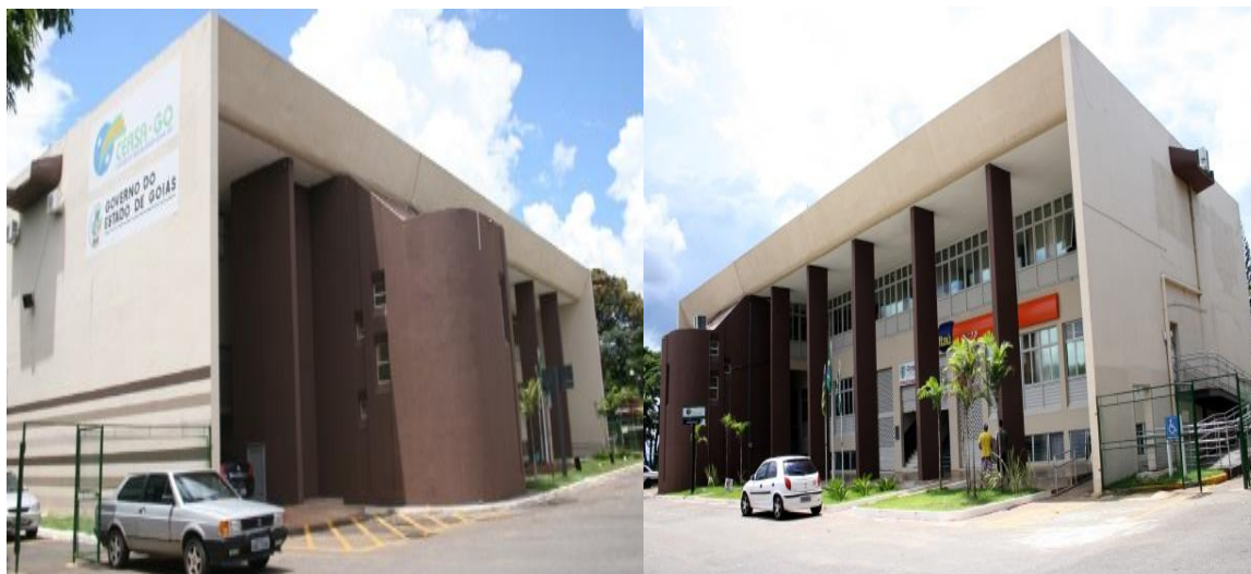
Figura 16: Prédio da Administração da Central de Abastecimento de Goiás – CEASA-GO
