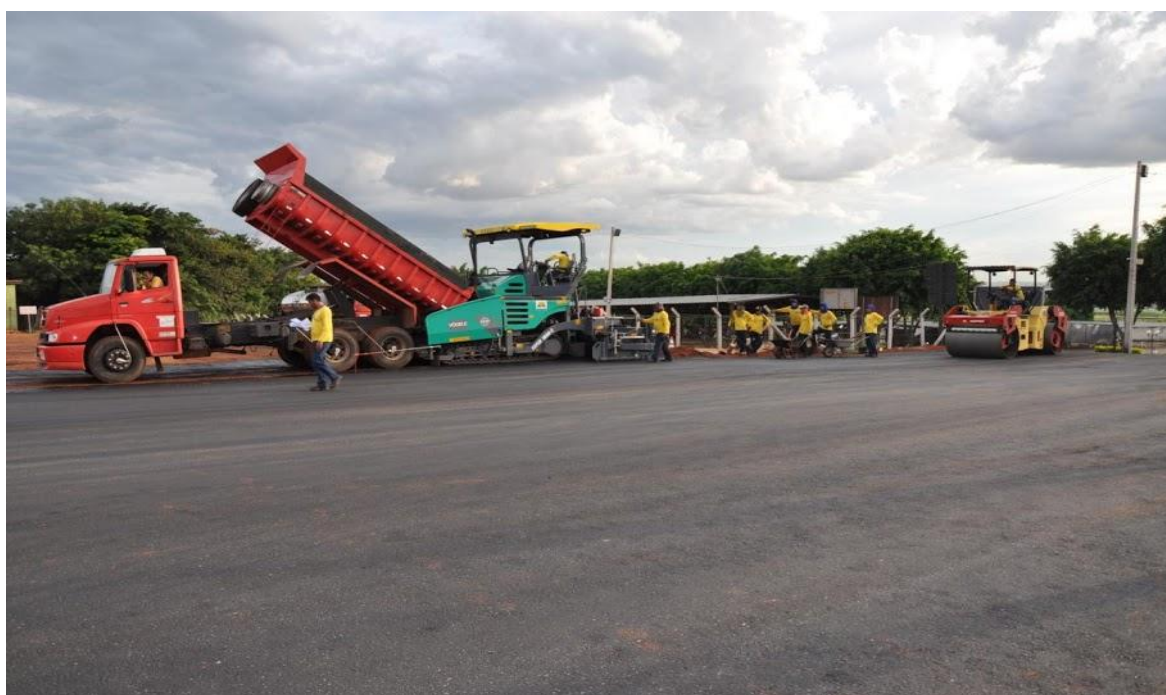
Figura 32: Pátio de Caminhões da Central de Abastecimento de Goiás – CEASA-GO
