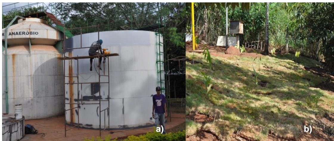
Figura 31: Estação de Tratamento de Esgoto da Central de Abastecimento de Goiás – CEASA-GO: a) Reforma da Estação de Tratamento de Esgoto, b) Recuperação de área degradada nas proximidades da ETE CEASA-GO
