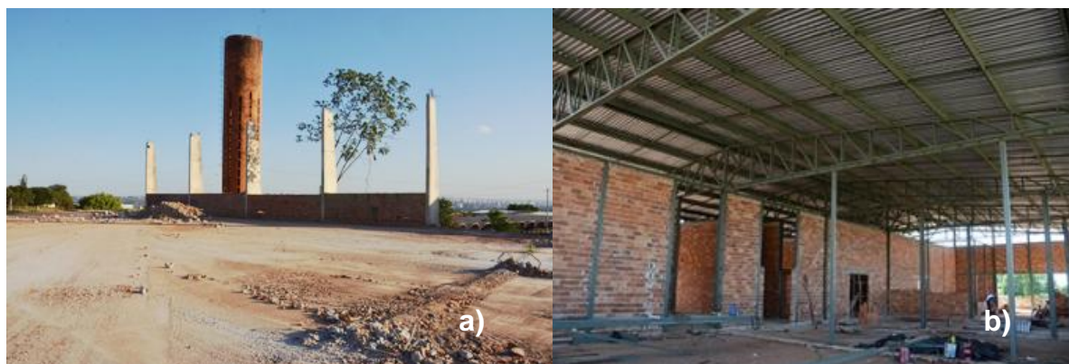
Figura 21: Construção do Novo Espaço do Banco de Alimentos da CEASA-GO; a) Área destinada à construção do Banco de Alimentos e b) Execução da alvenaria e da edificação da estrutura metálica
