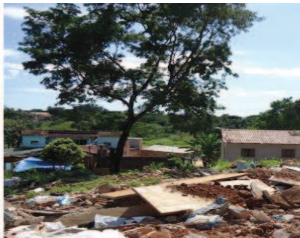
Área risco no Setor Negrão de Lima
