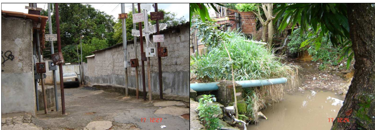
Figura 25 - Ligação de energia elétrica (esquerda) e Lançamento de esgoto clandestino (direita) Foto: SEPLAM/DPFT/Assessoria Técnica de Regularização Urbana
