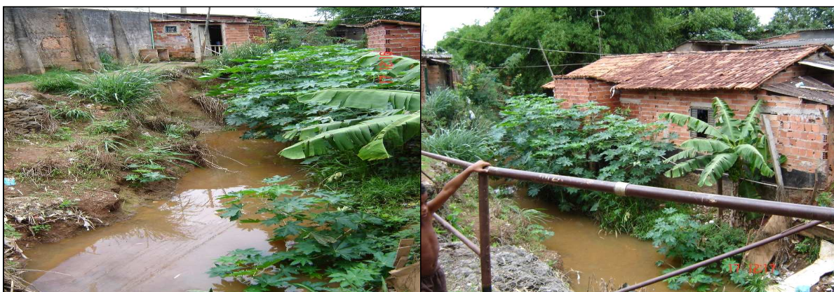
Figura 21 - Precariedade das edificações/proximidade com a água
