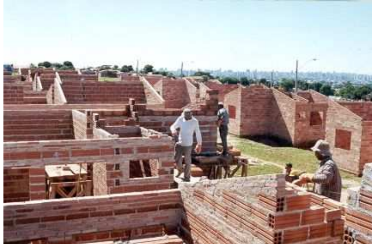
Figura 7 - Construção das Casas/ Programa PSH Fonte: Prefeitura de Goiânia. in www.goiania.go.gov.br/html/obras/habitacao/fotos/htm
