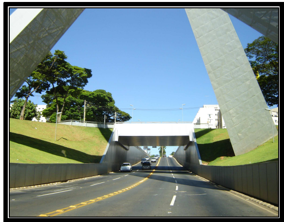
Figura 37 Viaduto da Praça Lafit Sebba – Praça do Ratinho Foto: Autor
