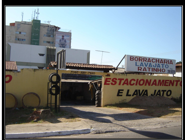
Figura 31 Estacionamentos no entorno da Faculdade Universo Fonte: Autor
