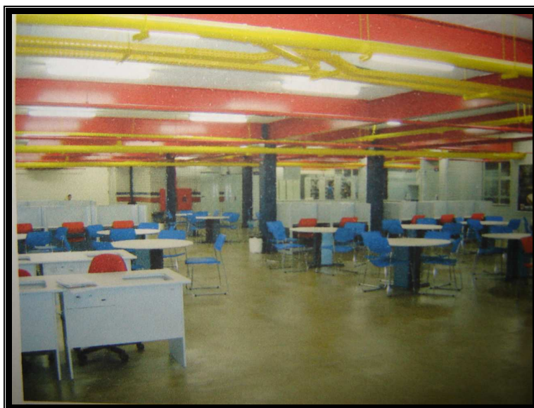
Figura 33 Ocupação irregular do subsolo, destinado no projeto a vagas de estacionamento. Foto: Autor
