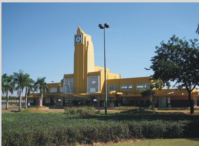
Figura 34: Estação Ferroviária. Adotada como sede do Centro de Formação Cultural, proposta do Projeto Estação Cultural, onde se propunha a instalação do café-teatro, da sala de vídeo, da biblioteca, da pinacoteca e da sala de artes plástica e música. (GOIÂNIA, 2004k). Fonte: Elane Ribeiro Peixoto.
