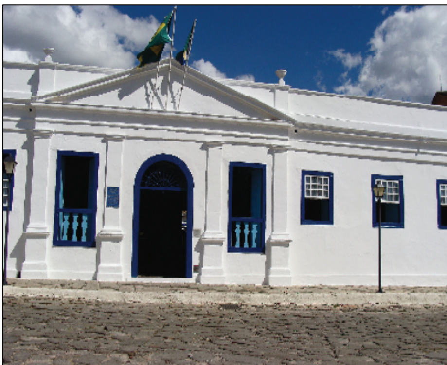
Figura 3 - Palácio Conde dos Arcos
