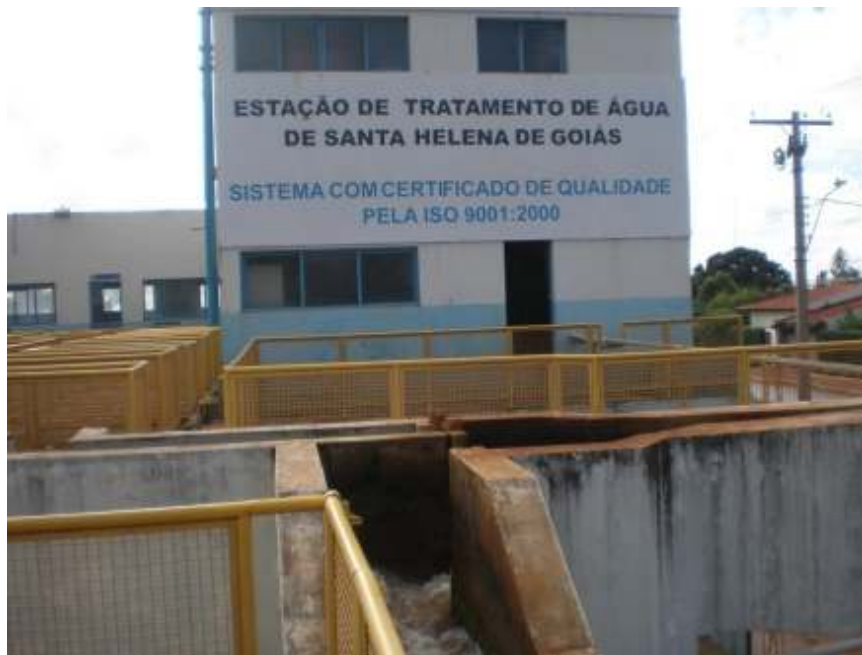
Figura 7. ETA – Estação de Tratamento de Água – município de Santa Helena de Goiás
