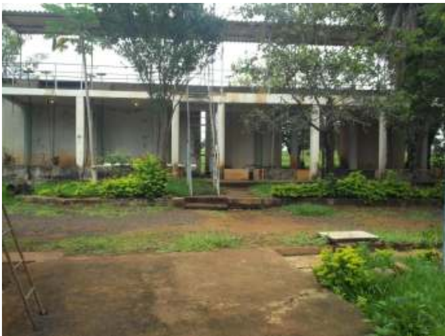
Figura 10. ETA – Estação de Tratamento de Água- município de Rio Verde
