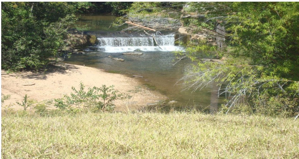
Figura 3- Assoreamento do Ribeirão Corrente, onde localiza a barragem de captação da ETA Minaçu-GO.
